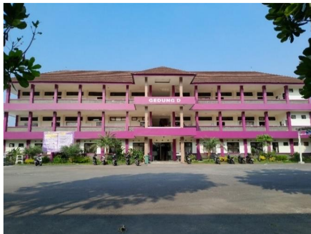
Gambar 3.1 Gedung D Fkominfo Uniga
